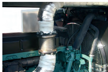
Compensatore gas di scarico Exhaust gas compensator Compensateur décharge
